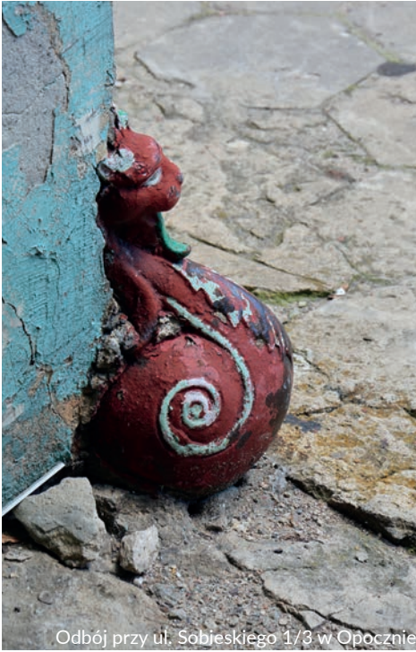
Odbój przy ul. Sobieskiego 1/3 w Opocznie
